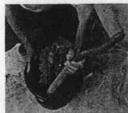
⑪用土小突き棒で固める
